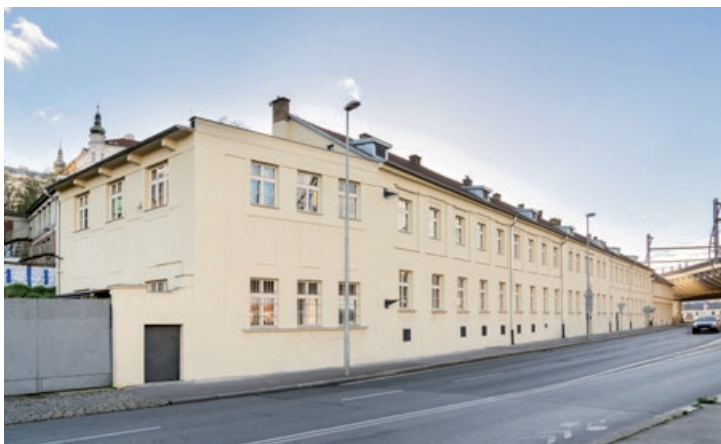
Pohled na Krenovku z Husitské ulice
